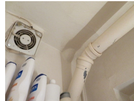
Aftrækskanal med el-ventilator
