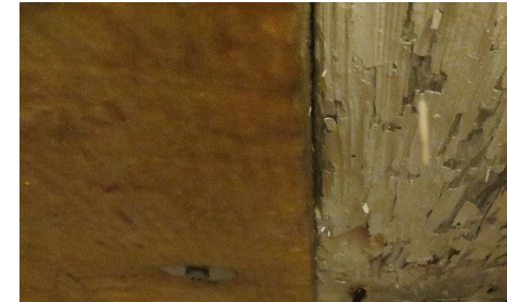
Isolering i kælder
