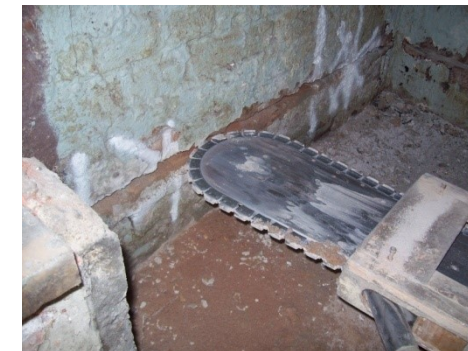
Eksempel på indskæring af fugtspærre
