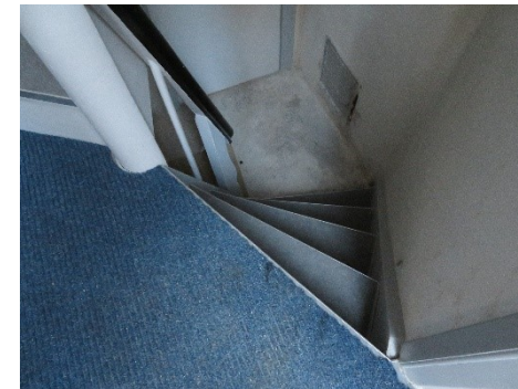
Trappeløb mod kælder
