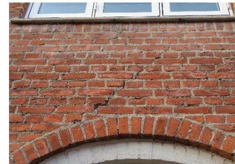
Sætningsrevne i gadefacade
