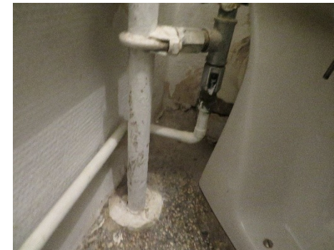
Galvaniseret stål og kobber i toiletrum
