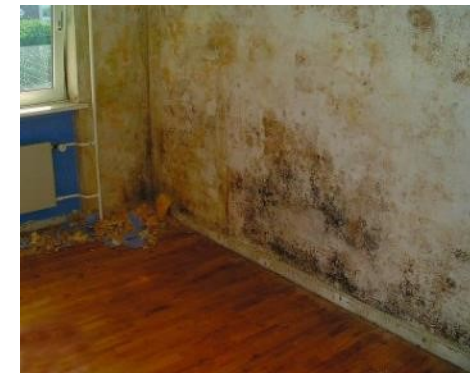
Eksempel på skade efter indvendig isolering Billedet er ikke fra jeres bygning
