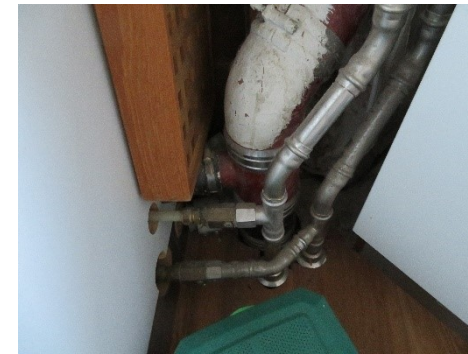
Rustfri installation i køkken
