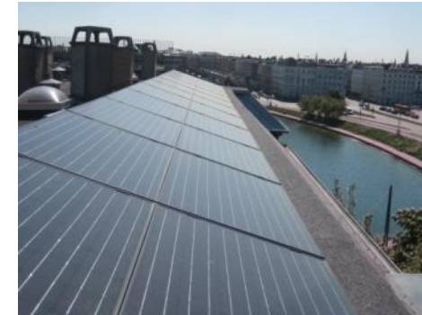
Eksempel på solcelleanlæg
