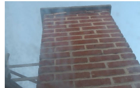
Løs fuge på skorsten
