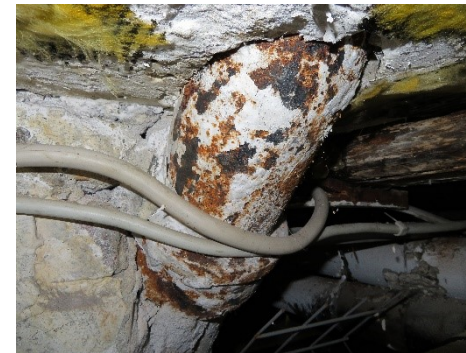
Toiletfaldstamme i kælder
